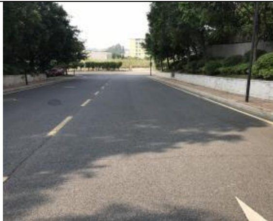
西面清华科技园广州创新基地内部道路
