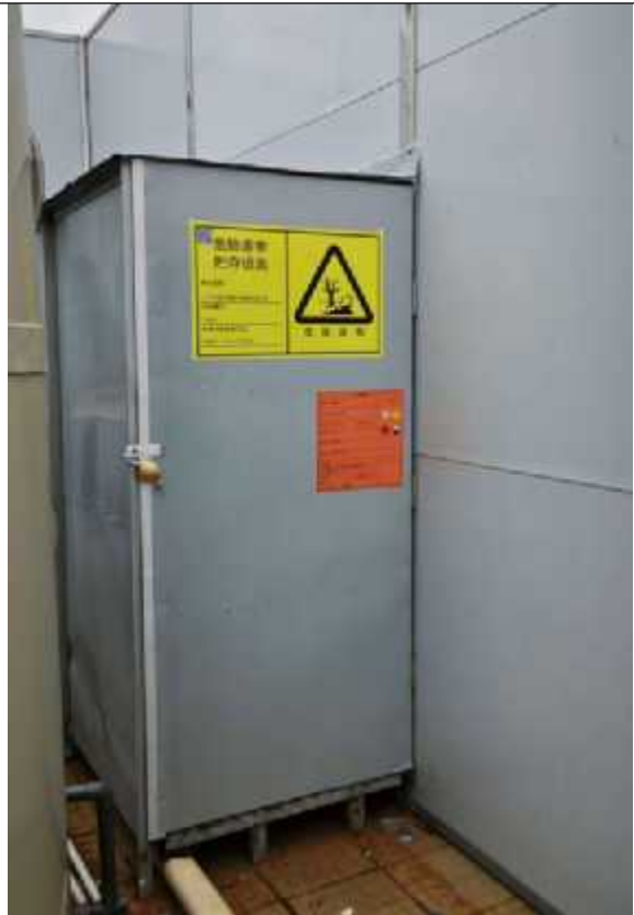
TS001 危险废物暂存间（远）
