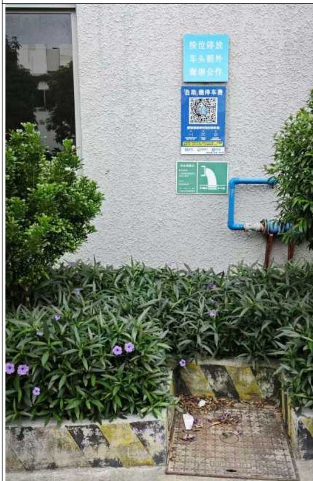
DW001 生活污水排放口（远）
